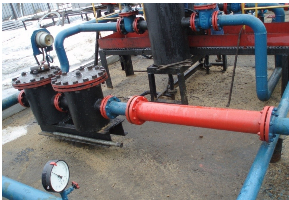
Рис. 9. Коагулятор перед системой фильтров на водоводе дожимной насосной станции «Бузовьязы» Уфимского УДНГ
