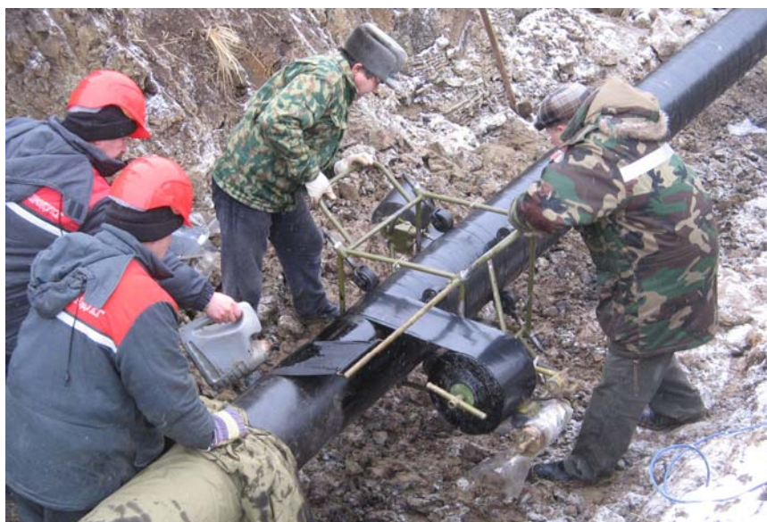
Рисунок 3. Нанесение изоляционного покрытия в трассовых условиях.
