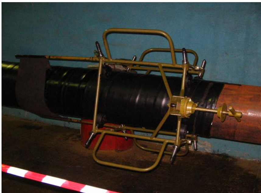
Рисунок 1. Устройство изоляционное типа «беличье колесо»
