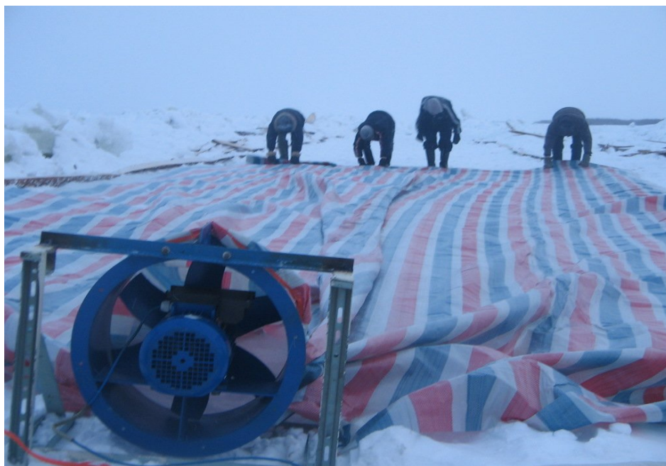
Рисунок 2. Монтаж установки по обдуву ледяной поверхности
