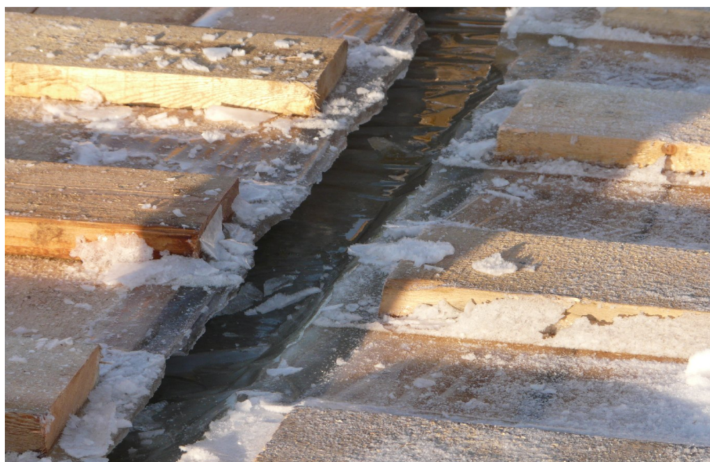
Рисунок 9. Сохранность деревянного настила при демонтаже
