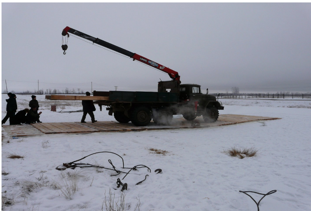
Рисунок 8. Усиление несущей способности болотистой местности
