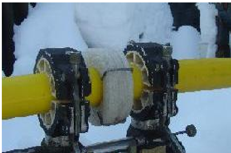
Рисунок 1. Общий вид теплоизоляционной камеры при сварке полиэтиленовых труб при температурах ОВ ниже нормативных
